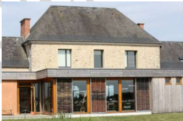
Plate 2: Maison du Parc, near Carentin
